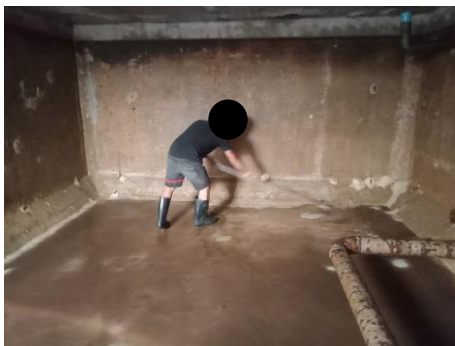
รูปที่ 2.1-25 การล้างถังเก็บน้ำสำรองโครงการ
