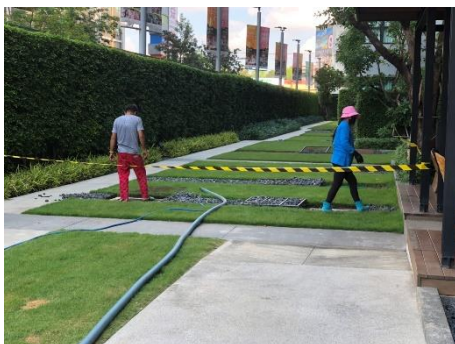
รูปที่ 2.1-20 สูบไขมัน และกากตะกอนส่วนเกินจากระบบบำบัด
