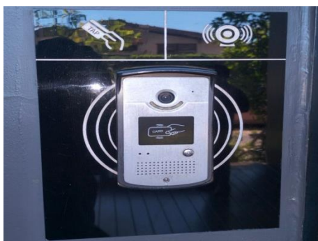
รูปที่ 2.1-39 ระบบประตูที่ควบคุมด้วยระบบอัตโนมัติ (Access Control) ใช้ระบบคีย์การ์ด
