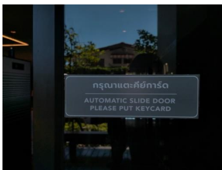
รูปที่ 2.1-39 ระบบประตูที่ควบคุมด้วยระบบอัตโนมัติ (Access Control) ใช้ระบบคีย์การ์ด
