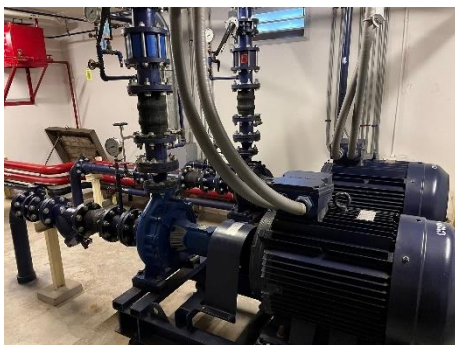
รูปที่ 2.1-22 ระบบสูบน้ำประปาในโครงการ
